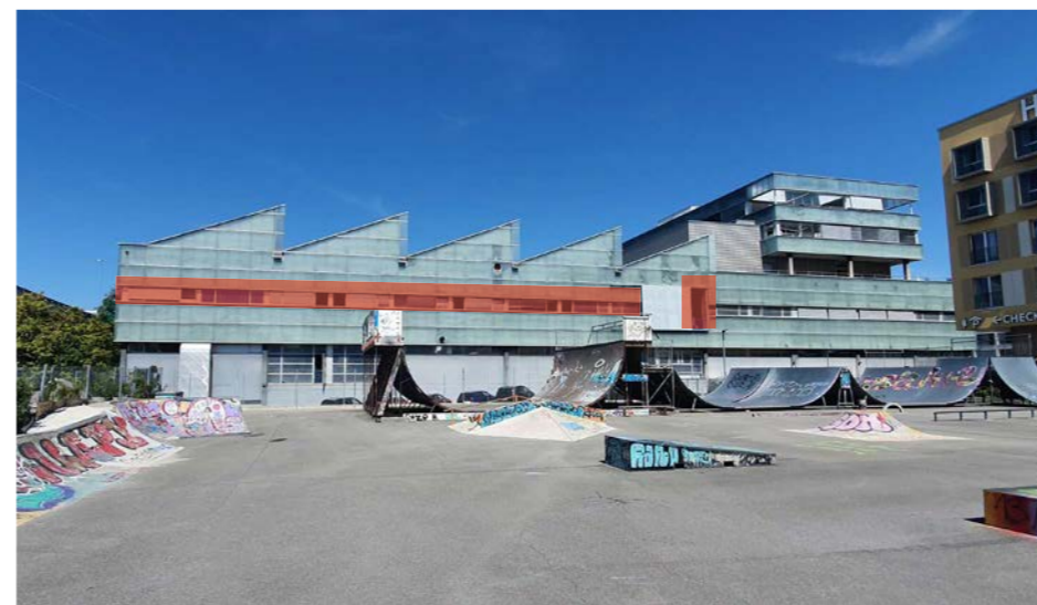
Bild 2 - Wäscherei, Lärmemissionen durch Fenster
